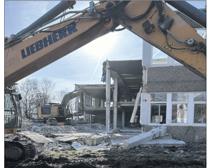
Das Hauptgebäude ist inzwischen komplett abgerissen.
