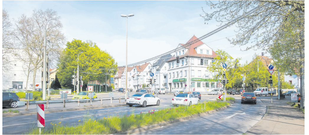
Ab Mitte Mai wird die Kreuzung von Schorndorfer Straße, Plochinger Straße und Ulmer Straße umfassend umgebaut. Foto: Stadt Esslingen
