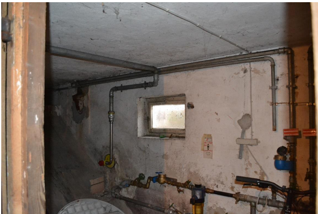
Abb. 4: Blick in den Kellerbereich des ehemaligen Kindergartens
